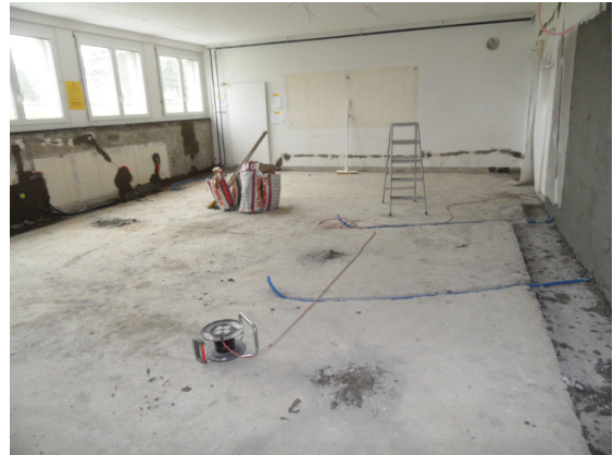
Schulküche im Rohbau-Zustand
