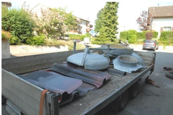
Der alte Öltank wird in seine Einzelteile zerlegt und entsorgt.
