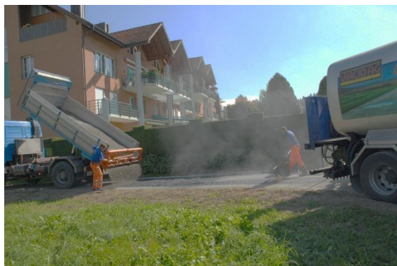
Zuerst wird die Oberfläche getränkt und dann mit Splitt bedeckt.
